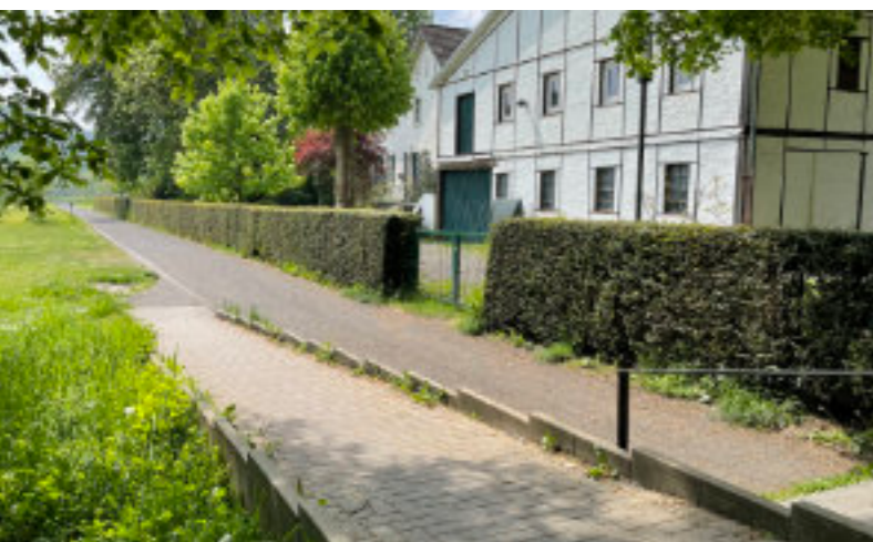
Die 1910 errichtete große Remise von Gut Eichthal
